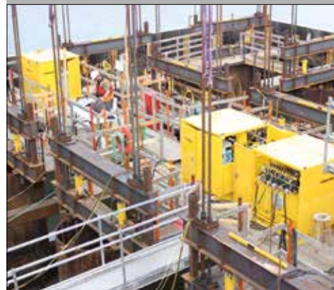
▲ Заказной гидравлический насос для системы надвигки мостов.
